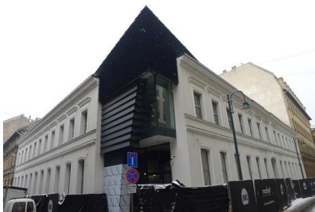
7. kép/ Az átalakítás utáni homlokzati kialakítás a kihangsúlyozott sarok bejárattal
