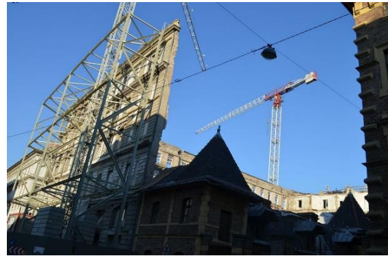
8. kép/ Pesti Hírlap nyomdája az építés idején, 9. kép/ Utcai főfalak megtartása a felújításkor
