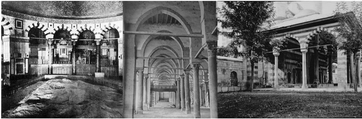
11. ábra: Különböző közel-keleti épületek vonórudas rendszerei (Jeruzsálem: Sziklamecset, Kairó: 'Amr ibn al'As mecset, Damaszkusz: Takiyy al-Sulaymaniyya), forrás: [12]
