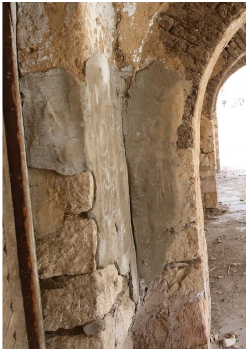
43. ábra: Mészkö lábázat vályoghabarccsal falazva forrás: saját fotó
