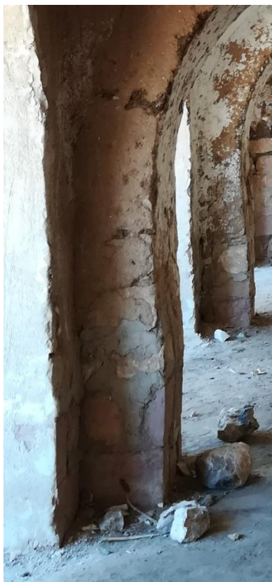
58. ábra: Kifelé dőlő pillérek, alsó függőleges és felső ferde szakasszal forrás: saját fotó
