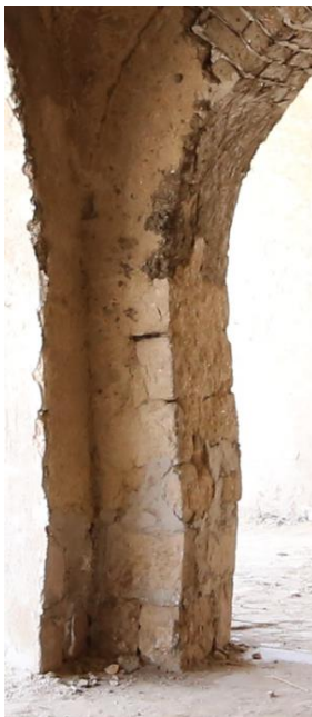
28. ábra: Képlékeny csukló a pillér középmagasságában forrás: saját fotó
