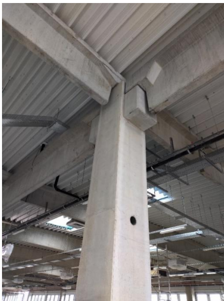
4, Előregyártott vasbeton pillér-gerenda kapcsolat 10
