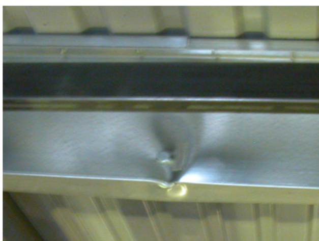
11. kép és 39. ábra: Z250 szelemen valós illetve numerikus tönkremenetele, átlapolásnál
