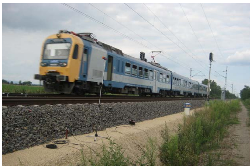
5.15. ábra – Mérőpont és környezete a W 14 sínleerősítés-rendszerű vágány mellett [28]
