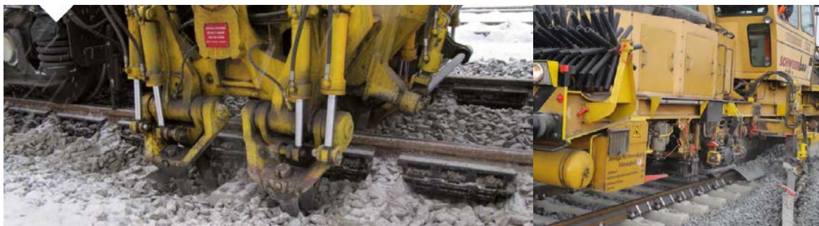
3.19. ábra – Felszerelt sínkamra elemek melletti zavartalan munkavégzés (STRAILastic) [27]
