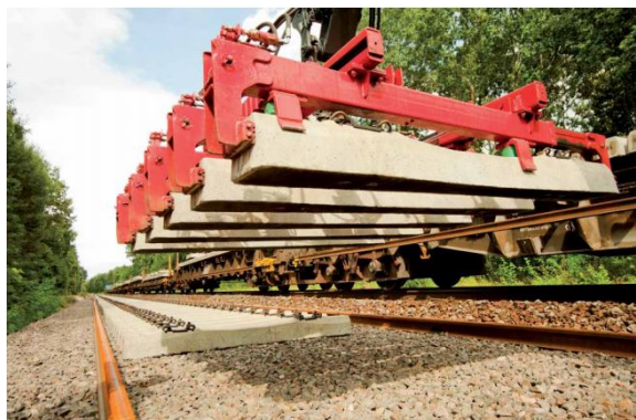
3.16. ábra – Alul Sylomer ® USP-vel ellátott vasbeton aljak telepítése [21]
