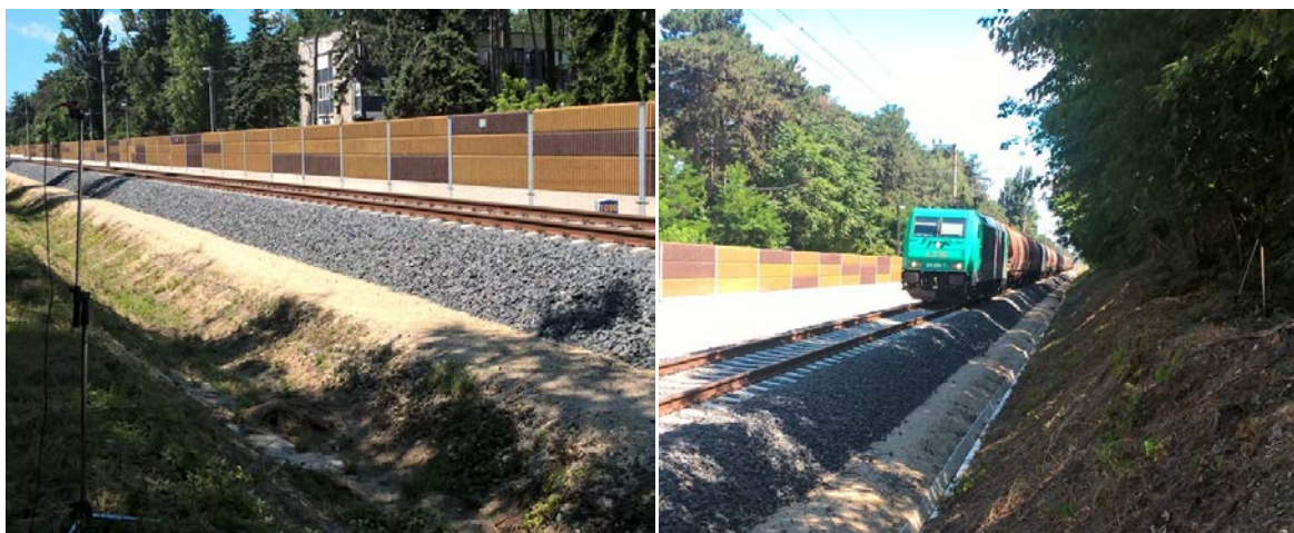
5.12. ábra – Referencia mérőpont az 1096-as szelvénynél (balra) és az aljpuccsal ellátott vágány melletti mérőpont az 1101-es szelvénynél (jobbra) [28]
