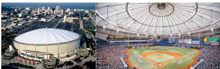
1.7. ábra. A floridai Tropicana Field Geiger-féle kábelkupola-lefedése. [17]
