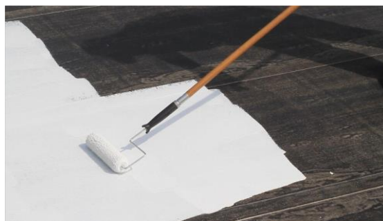
20. ábra - Hővisszaverő bevonat felhordása [19]
