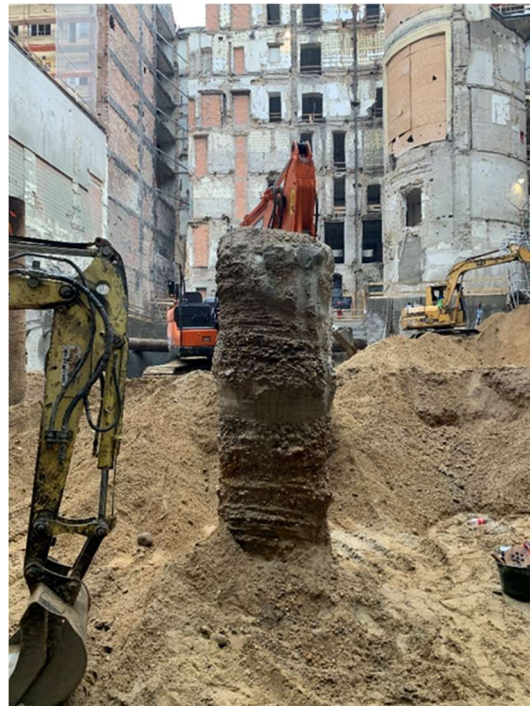
4. kép: Próbaoszlop (saját kép)
