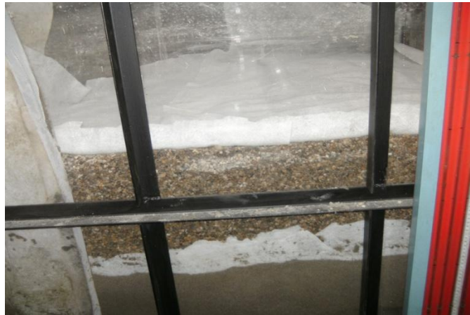
5.1. kép Geotextília beépítés a rétegek közé
