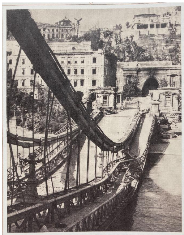
3.14. ábra: A budai nyílás kettétört pályalemeze [6].
