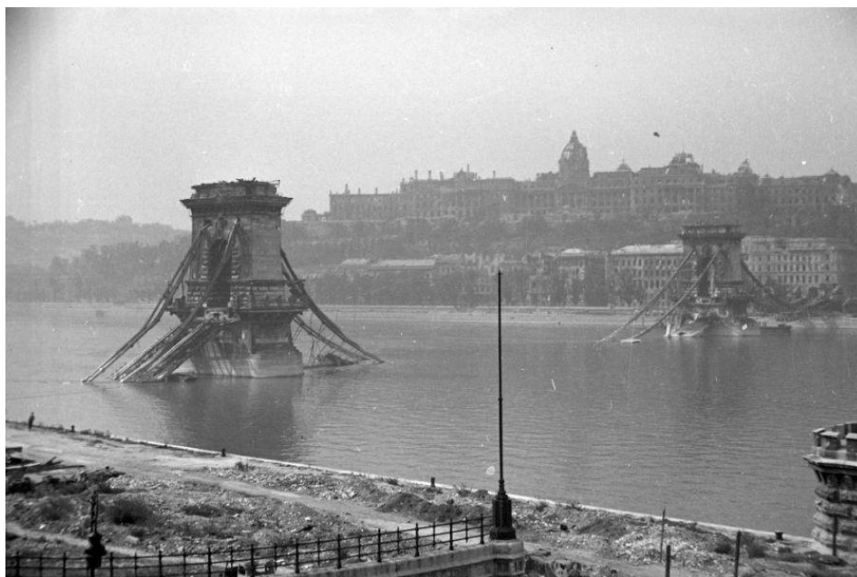
3.13. ábra: A felrobbantott Lánchíd 1945-ben [18].
