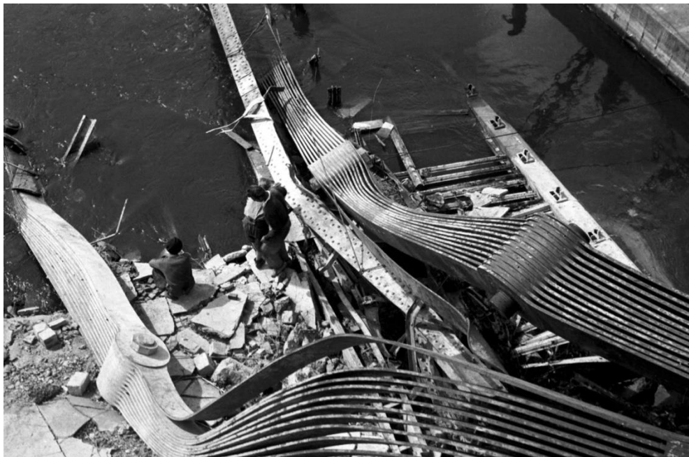
3.15. ábra: Elhajlott láncköteg a Dunában [19].
