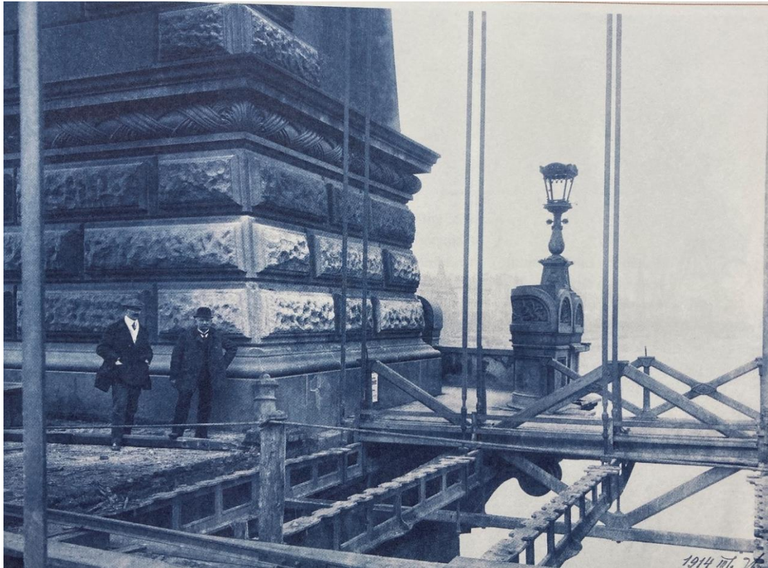
3.6. ábra: Az 1849-es szerkezet fa járdája és faszervezetű merevítőtartója [6].
