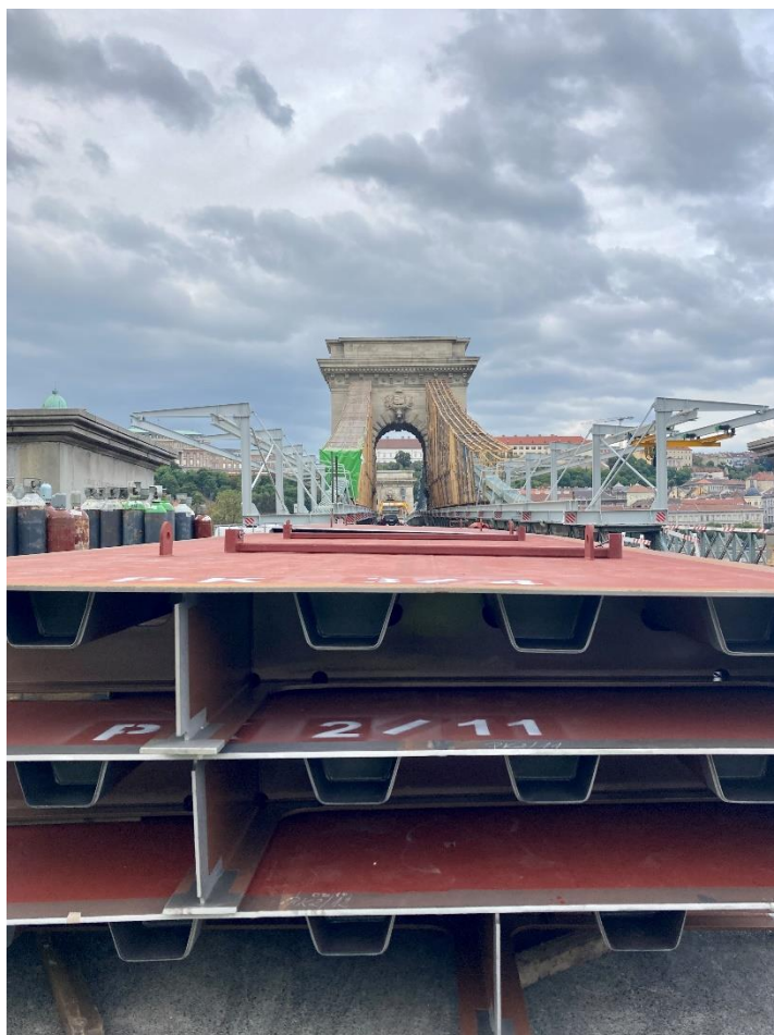
4.4. ábra: Új ortotrop pályalemezek az építkezés helyszínén.
