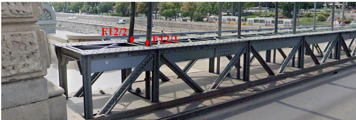
5.8. ábra: Nyúlásmérő bélyegek pozíciója a függesztőrudakon általános esetben.
