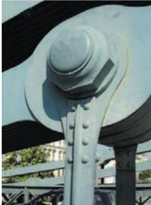
4.2. ábra: A függesztőrúd és láncköteg kapcsolata [1].
