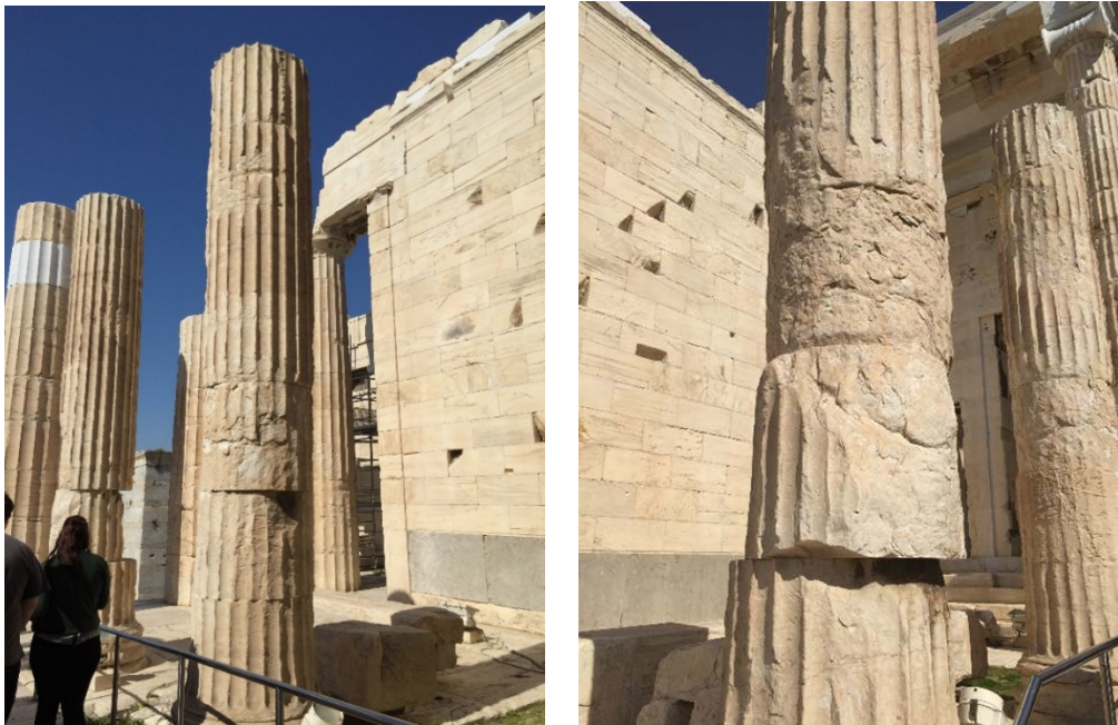
3. ábra – Károsodott oszloptörzsek az athéni Akropoliszban [4]
