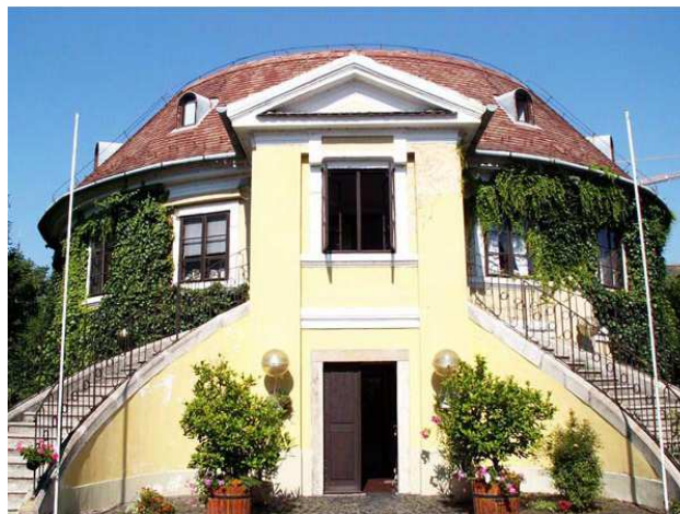
9. ábra Selyemgombolyító bejárata (forrás: http://budapestcity.org )
