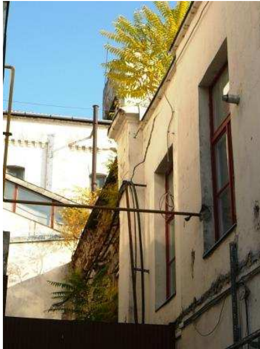
15. ábra A 3. számú épület nyugati homlokzatának biológiai károsítói
