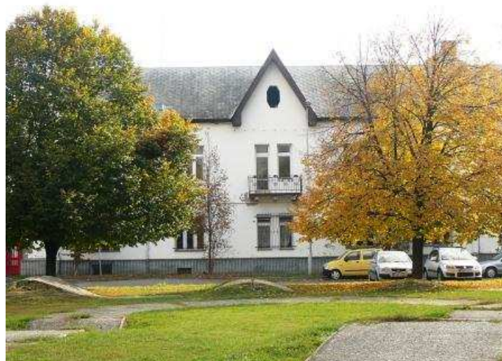
28. ábra A 2. számú épület nyugati homlokzata
