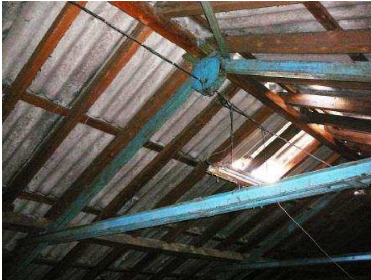
23. ábra 36/c számú épület függesztőműves fa fedélszéke és hullámlemez fedése
