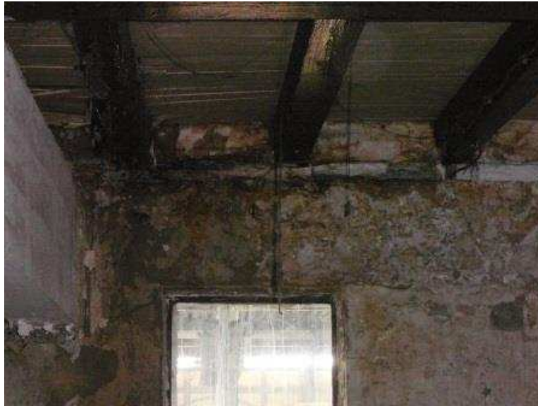
17. ábra A 36/g számú épület zárófödeme belülről
