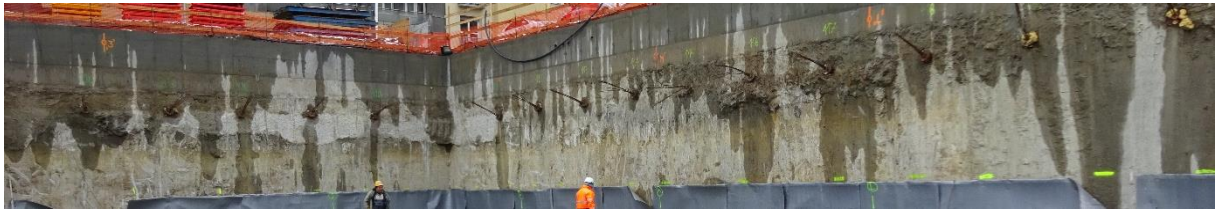
2. ábra Elkészült résfal részlete
