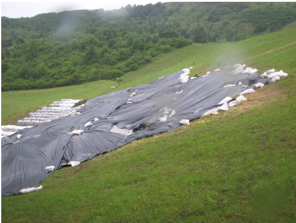
3. kép. Védekezés a suvadás ellen. Forrás: Takács Attila
