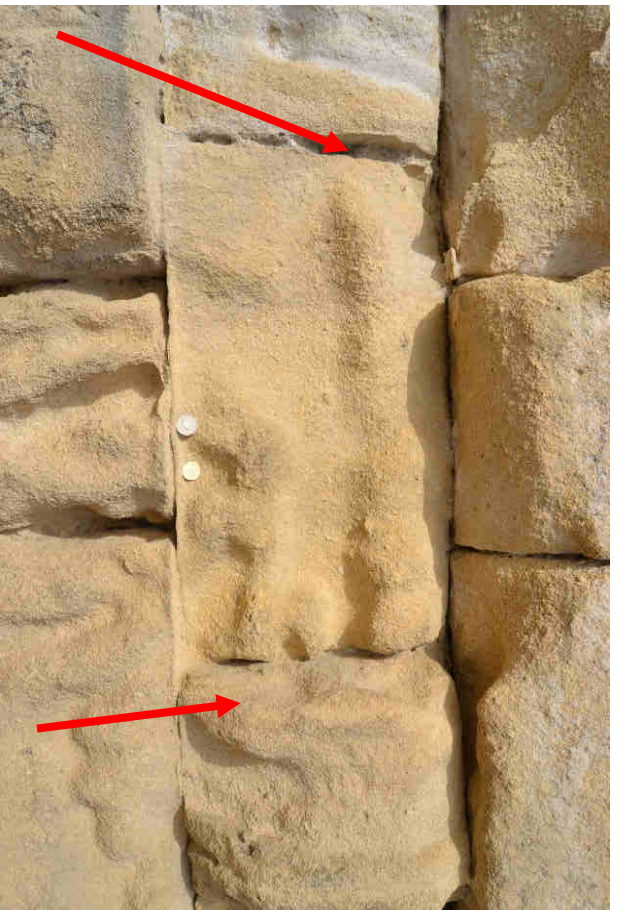
19. ábra: Visszahátrált kötömbök a K_14 falszakaszon (D-i oldal, D-i fekvés)
