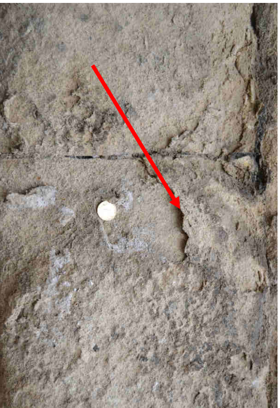
18. ábra: Levéló fehér kéreg a K_14 falszakaszon (D-i oldal, D-i fekvés)
