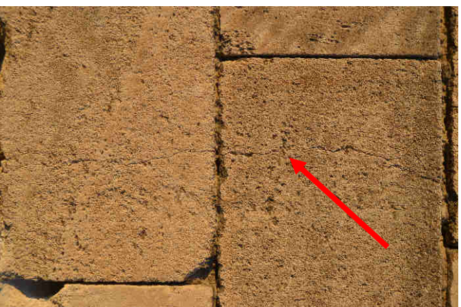
20. ábra: Statikai problémákra visszavezethető kötőmb átrepedés több soron keresztül (K_14-es falszakasz, D-i oldal, D-i fekvés)
