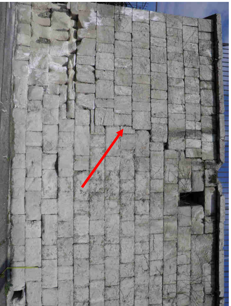
24. ábra: Cserélt kötőbökökből újjarakott falazat
