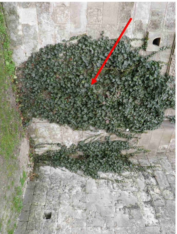
26. ábra: Nagy kiterjedésű borostyán a K_09 falszakaszon
