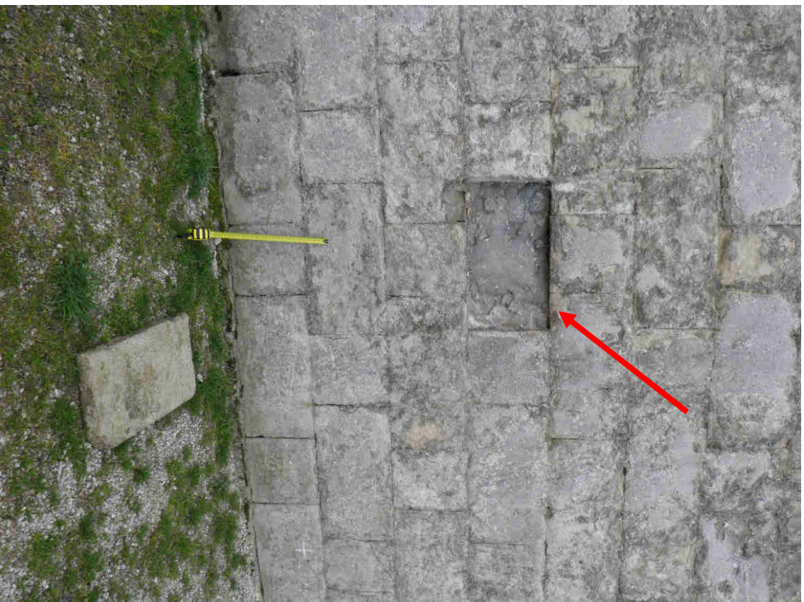
25. ábra: Helytelenül rögzített, kiesett kőlap
