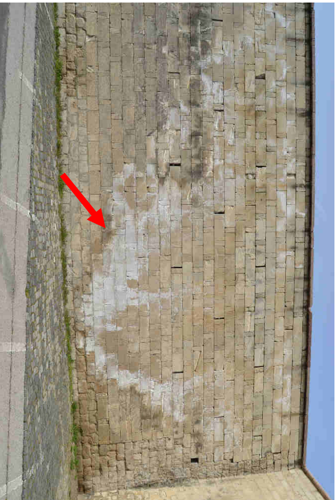
6. ábra: Nagy felületre kiterjedő sókivirágzás (Citadella D-i oldal, D-i fekvés)
