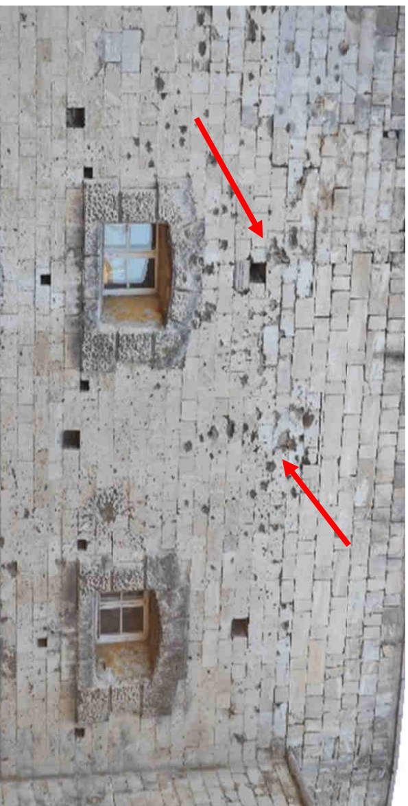
21. ábra: Belövések nyomai a K_20-os falszakaszon (D-i oldal, K-i tájolás)
