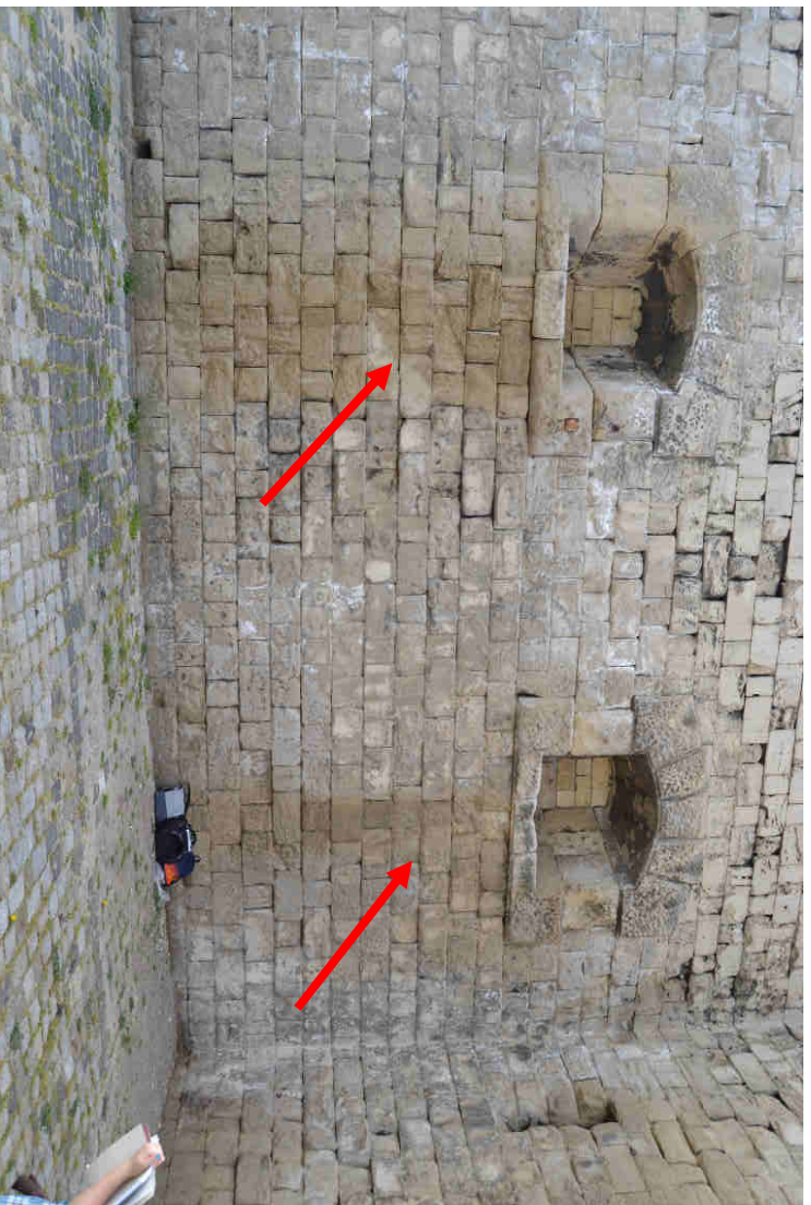
30. ábra: Barna elszíneződés a K_15-ös falszakaszon (déli oldal, keleti tájolás)
