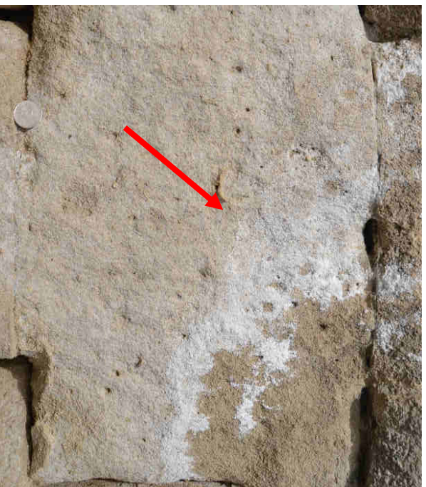
29. ábra: Sókivirágzás a K_14 falszakaszon (déli oldal, déli tájolás)
