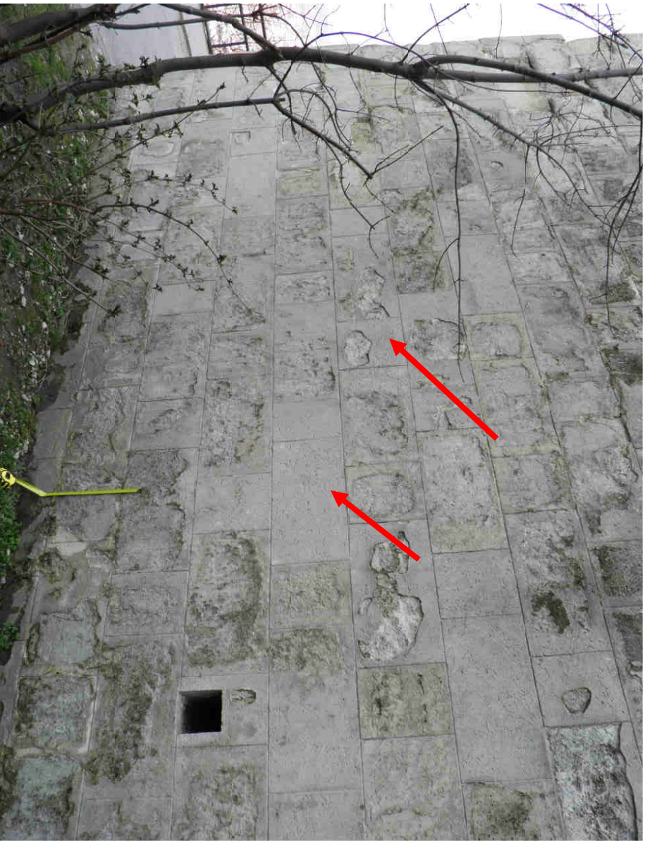
22. ábra: Nagy felületen, kikenéssel javított falazat
