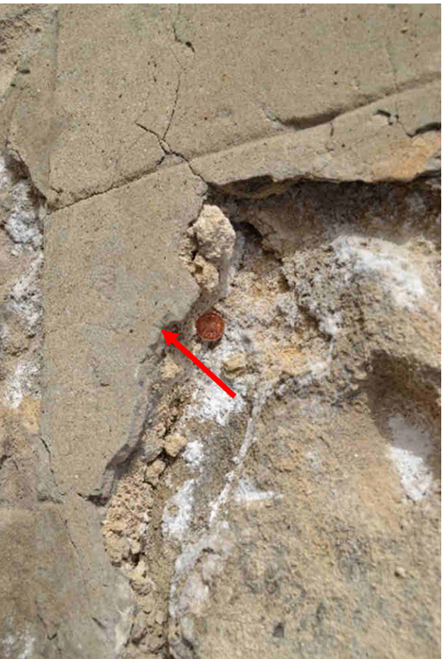
23. ábra: Cementkikénés mellett tönkrement kőzet
