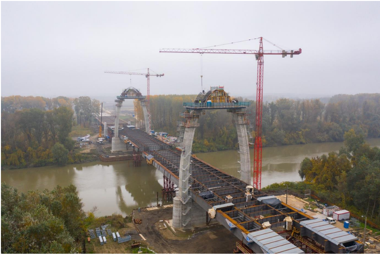
36. ábra: A merevítőtartók tolás közben [32]
