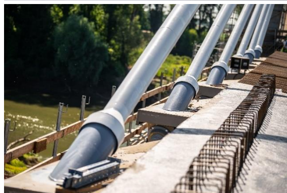
4. ábra: Kábelek lehorgonyzása [2] [5]
