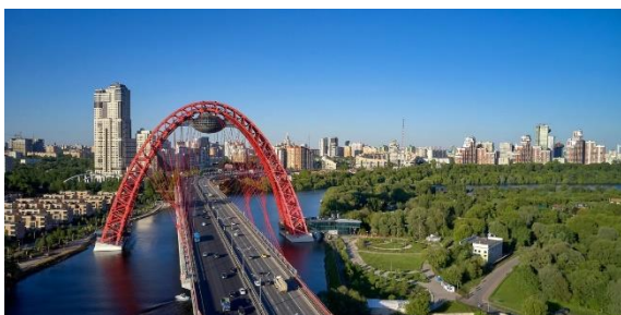
24. ábra: Zhivopsiny Bridge [26]
