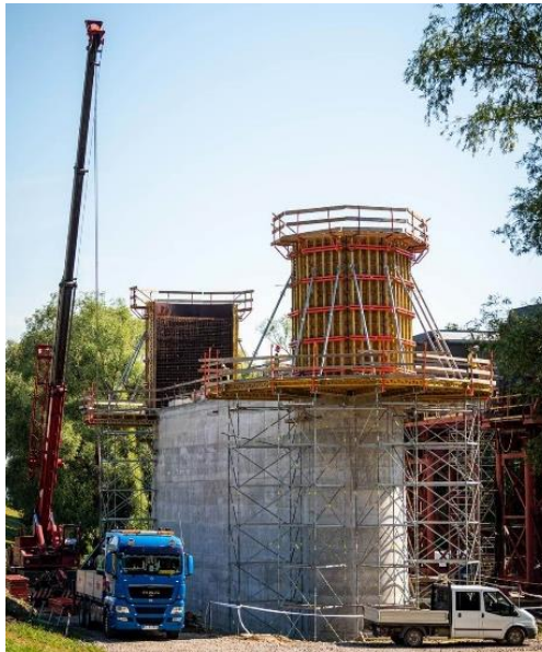
35. ábra: Monolit vasbeton pillér építése [30]
