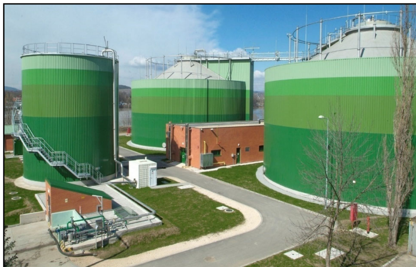
16. ábra - Anaerob mezofil rothasztók az Észak-pesti Szennyvíztisztító Telepen Forrás: Fővárosi Csatornázási Művek Zrt.
