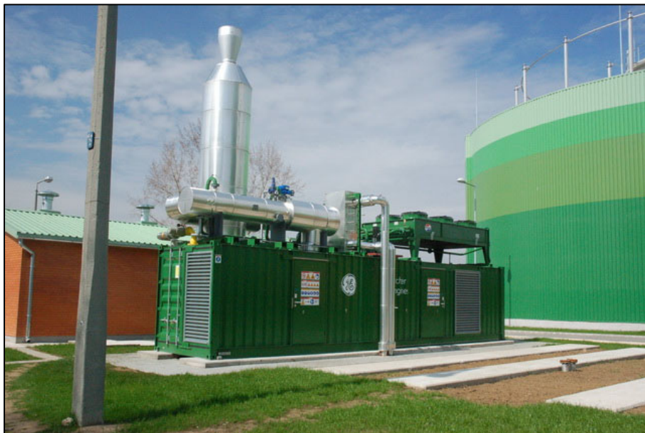
14. ábra - Gázmotoros rendszer az Észak-pesti Szennyvíztisztító Telepen, 2008. Forrás: Fővárosi Csatornázási Művek Zrt.
