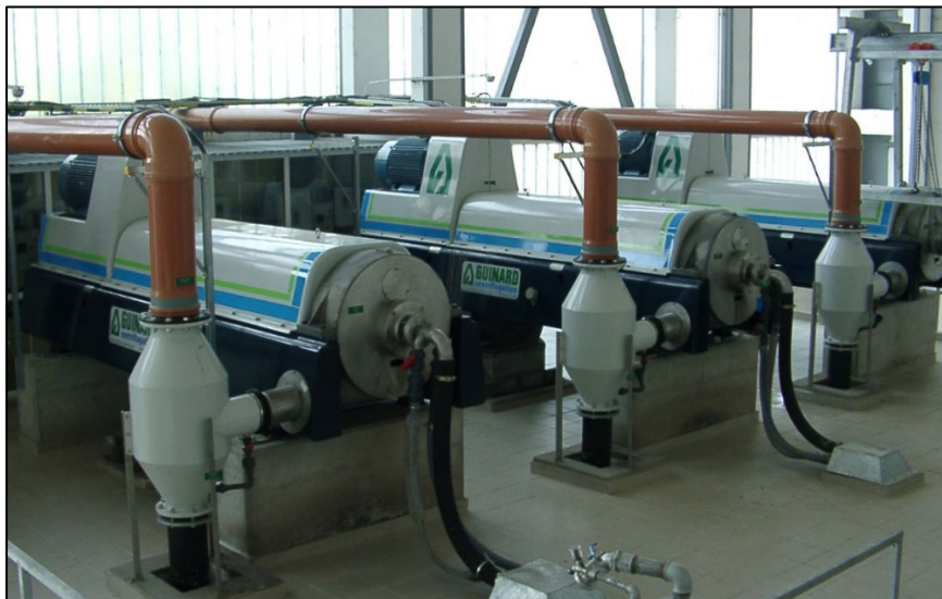
12. ábra - Iszapsűrítő centrifugák az Észak-pesti Szennyvíztisztító Telepen, 2001.
