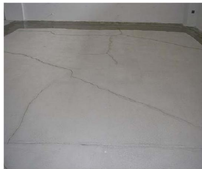
b) hálós repedés
