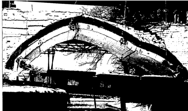
23. ábra – Prestwood Bridge tönkremenetel állapota [18]
