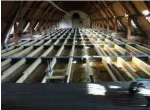
11. ábra Duofor rendszer trapézlemez megerősítése [T3]
