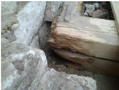
4. a., 4. b. ábra Beépített gerendavégek károsodása és feltárása [www13.]
