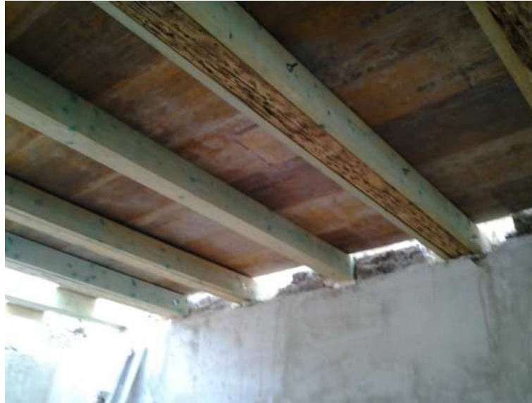
5. ábra Födémgerenda megerősítése a gerendakeresztmetszet megnövelésével [www13.]
