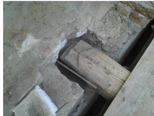
4. a., 4. b. ábra Beépített gerendavégek károsodása és feltárása [www13.]
