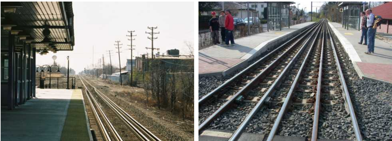
42. ábra. Vágányfonódással kialakított peron a New Jersey Transit egyik állomásán [17] (balra); Hármass fonódással kialakított peron a Kasseli Tram train vonalán [16] (jobbra)
