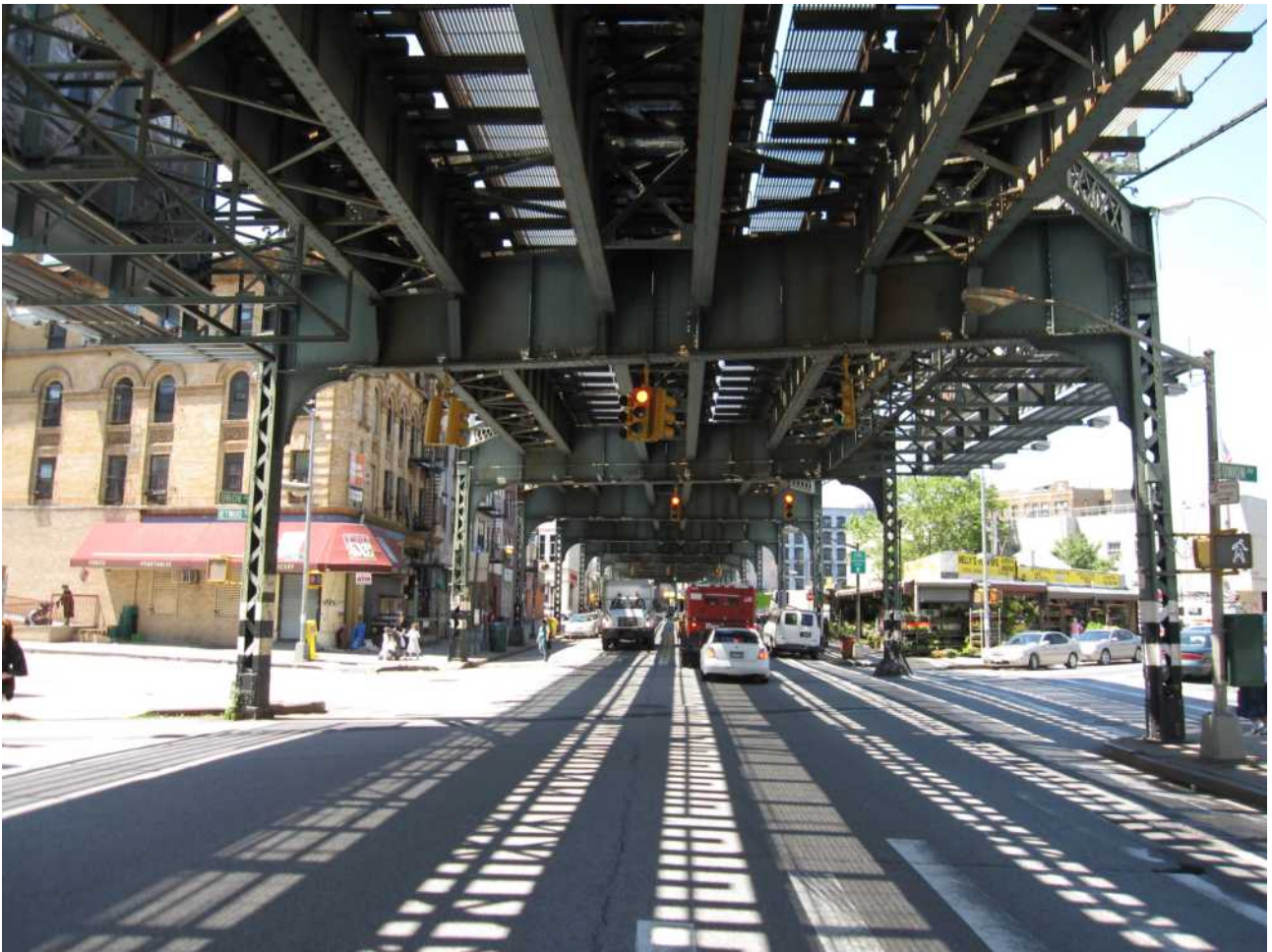
6. ábra. Acélszerkezetes magasvezetésű városi gyorsvasút Brooklyn (USA) utcái felett [9]
