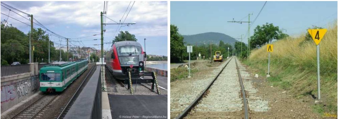
10. ábra. Szerelvény fordulása a Margit hídi csonkavágányon [11] (balra); Az Óbudánál feljavított MÁV - HÉV összekötő vágány [45] (jobbra)
