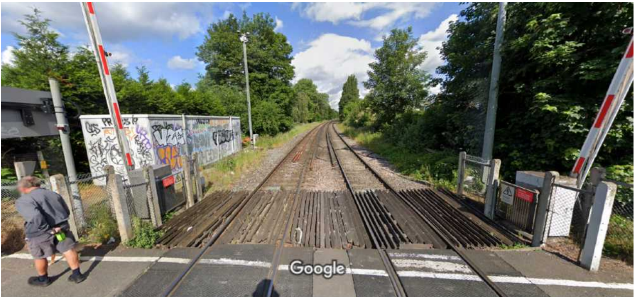
49. ábra. Elővárosi vasúti pálya harmadik sínnel villamosítva London külvárosában. A képen látható, hogy a sínek közé helyezett akadályokkal próbálják visszatartani az illetéktelen pályáralépést.
