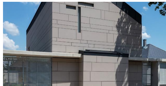
2. ábra: Luther-kápolna (Budapest) szálcement homlokzatképzéssel https://www.equitone.com/hu
