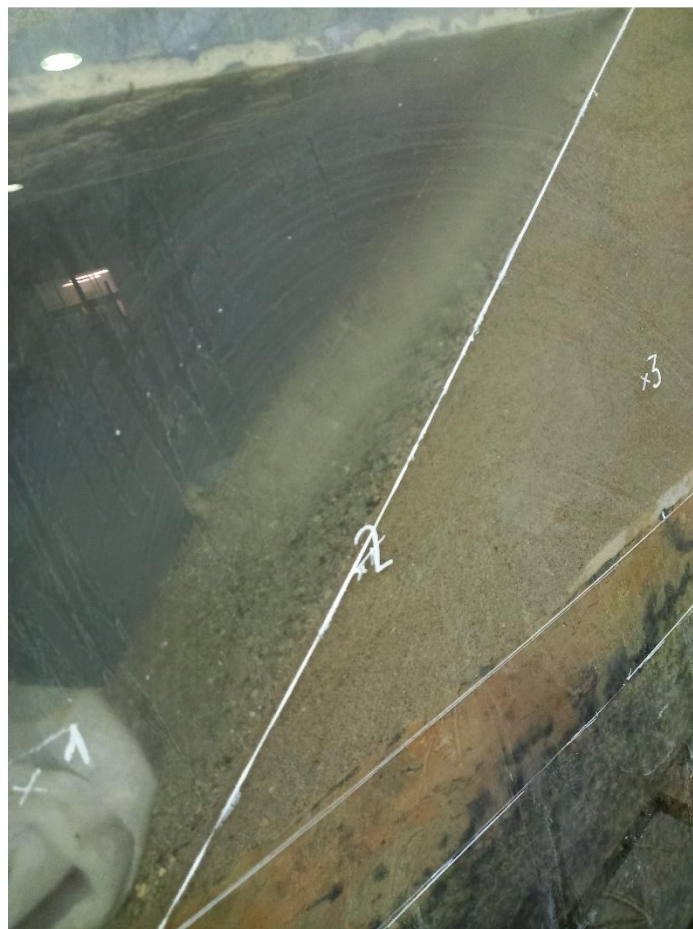
7. Kép: Árvíz oldali enyhe kimosódás
