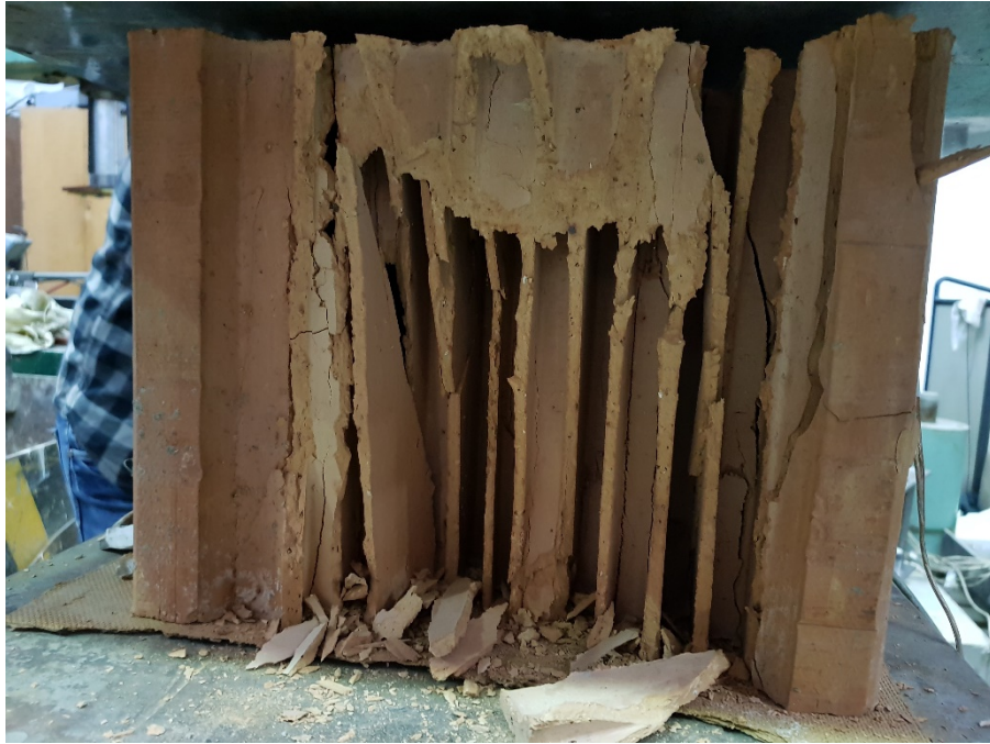
13. ábra: Tönkrement falazóelem
