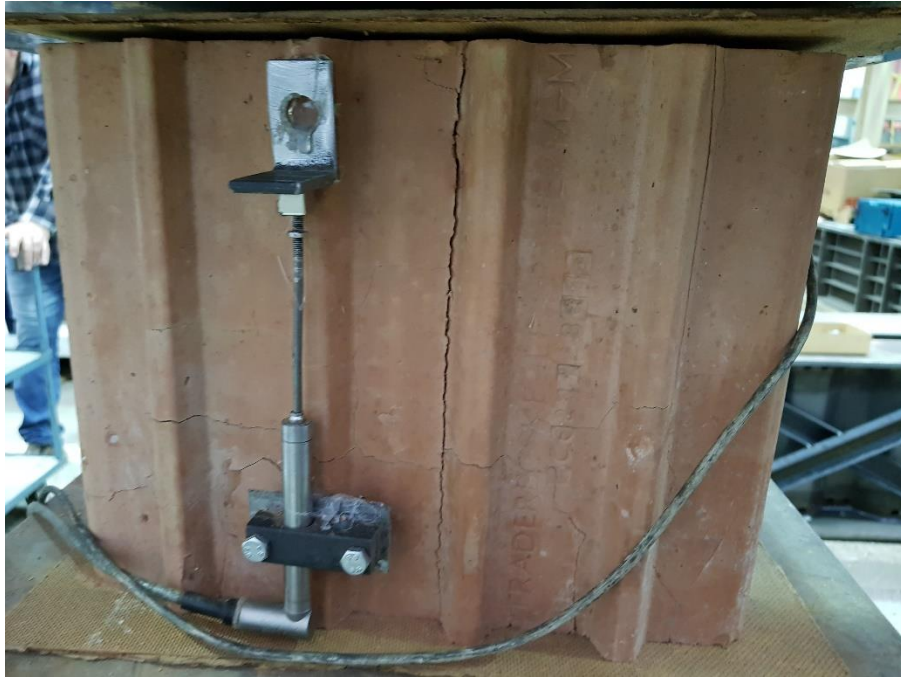
12. ábra: Függőleges repedés
