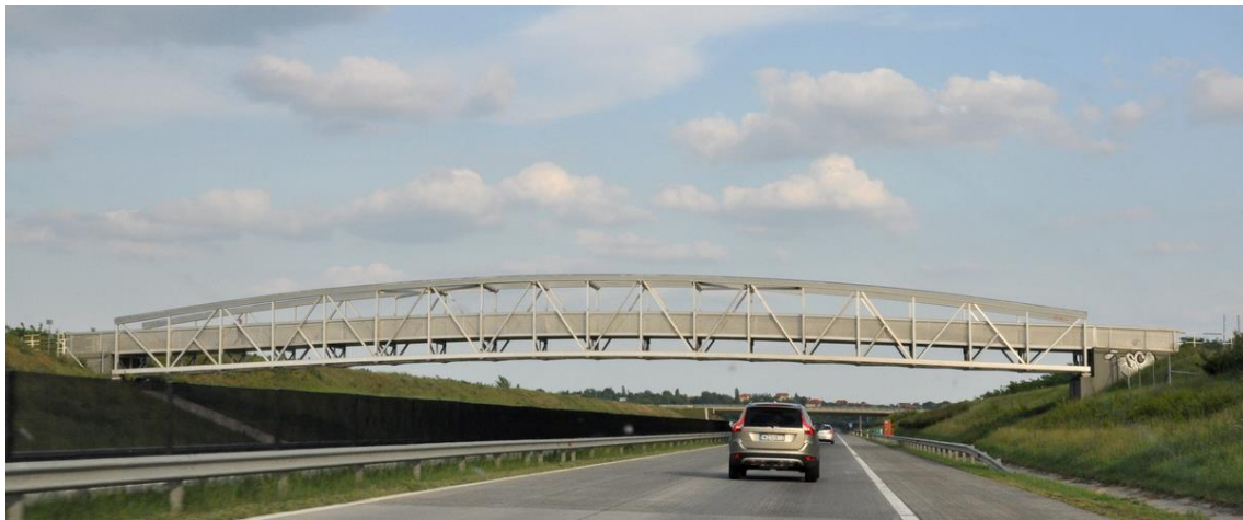
2. ábra – Csömöri gyalogos híd, tiszta alumínium szerkezet (forrás: https://hu.wikipedia.org/wiki/Csömöri_gyalogos_híd )
