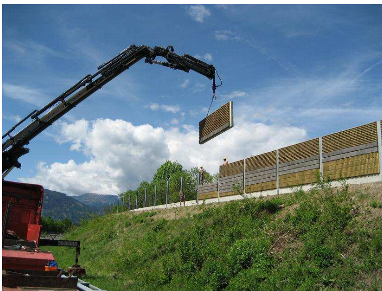
39. ábra - Fabeton elemekből álló zajvédelmi létesítmény építése [28]
