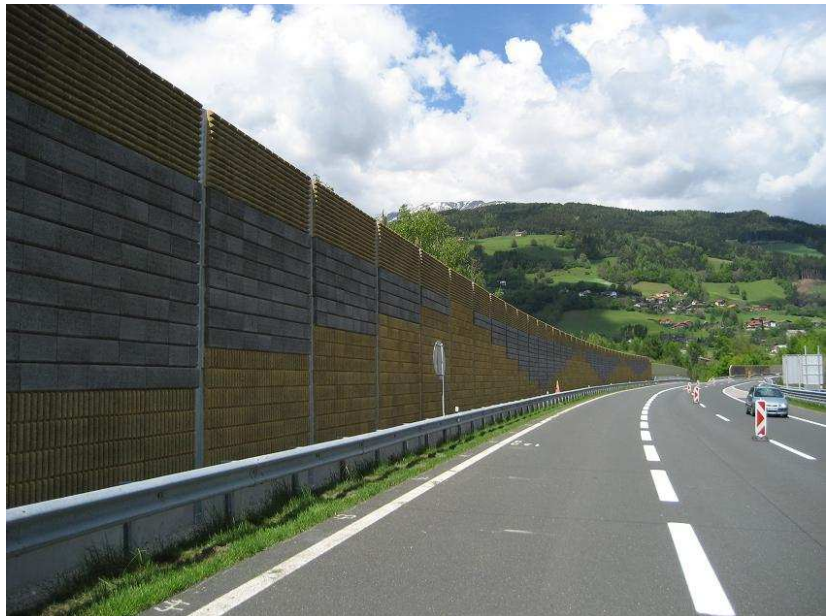
25. ábra - A megfelelő vizuális vonalvezetés megkönnyíti a tájba illesztést [7]
