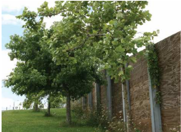
19. ábra - A tervezés során a fal "túlsó" oldaláról sem szabad megfeledkezni (Auckland NZ) [7]
