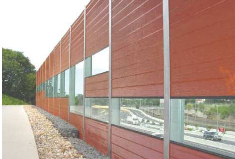
23. ábra - Az átlátszó panelek alkalmazása növeli a tájékozódást és a közbiztonságot [7]
