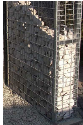
35. ábra - A Gabion zajfogó kialakítása [27]
