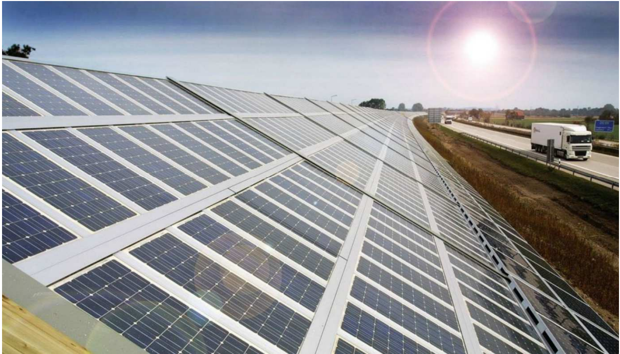
38. ábra - Fotovoltaikus zajvédő fal (Freising, Németország, A92) [29]
