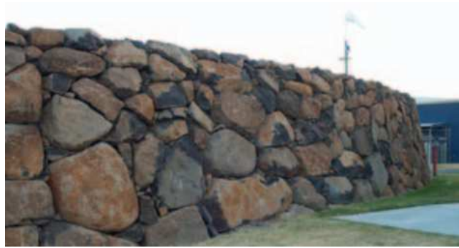
36. ábra - Magán jellegű kőből épített zajvédő fal, Tweet Heads kórház [6]
