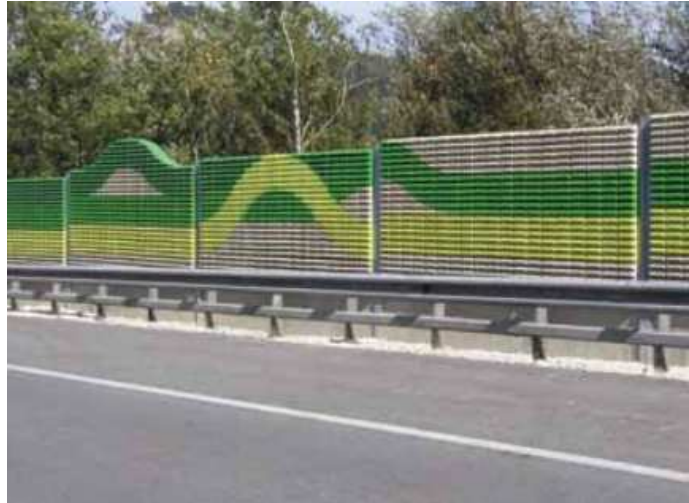
10. ábra - Modern jellegű fabeton típusú zajvédelmi fal [28]
