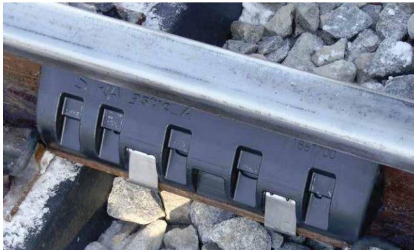
13. kép STRAILastic_A_inox kamraelem beépítve az élópályában
