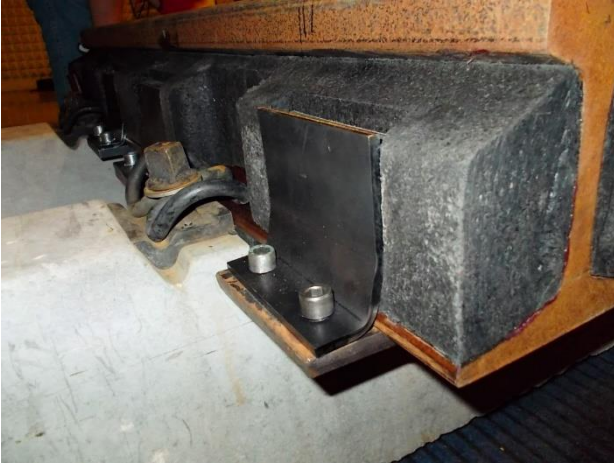
7-8. kép SOFIDON-T típusú kamraelem szerelve és ragasztott módszerrel felhelyezve
