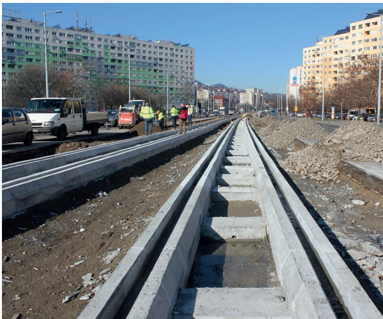
25. ábra: A hosszgerendás pálya építése. (Kép forrása: www.innorail.hu )
