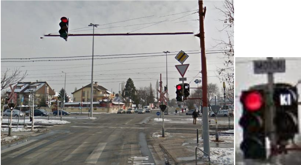
26-27. ábra: A MOTOR KI-MOTOR BE jelzőlámpa. (Kép forrása: Google Earth )
