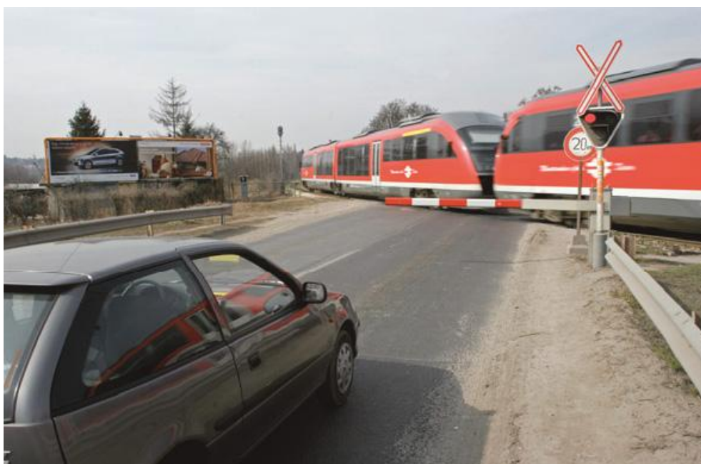
27. ábra Fény és félsorompóval biztosított szintbeni vasúti kereszteződés 48
