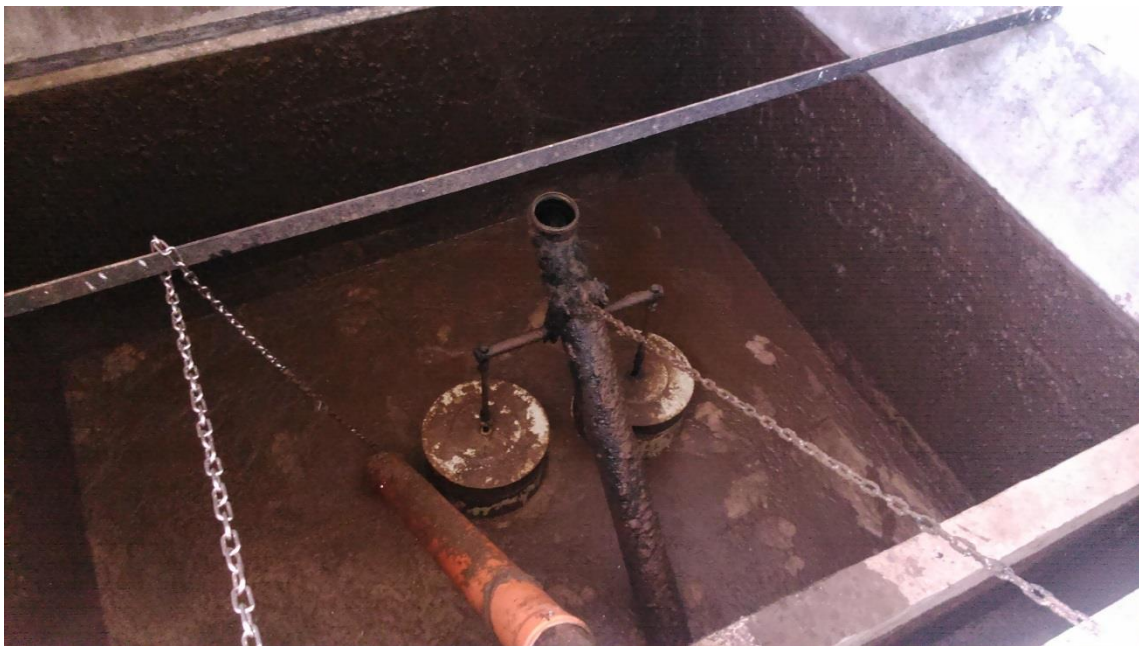
10. kép: Sűrítő átalakított bevezetéssel
