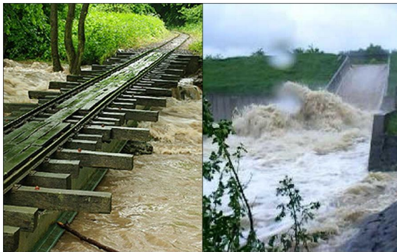
6. ábra: Műtárgyak áradáskor a patakon (erdei vasút hídja és a vészárasasztó)
