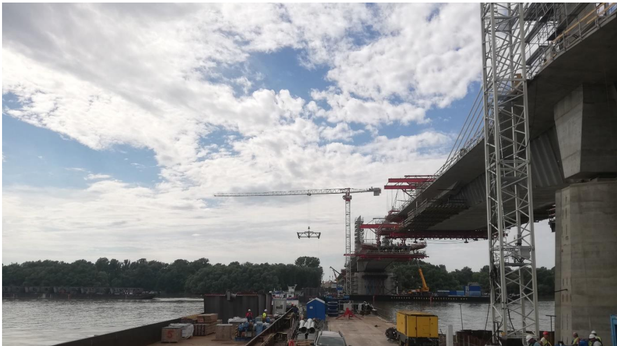
5. ábra: Acélszegmens pályalemezre emelése
