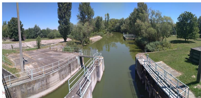
2.3.5.2. ábra: A 4T műtárgy, balra a hallépcső
