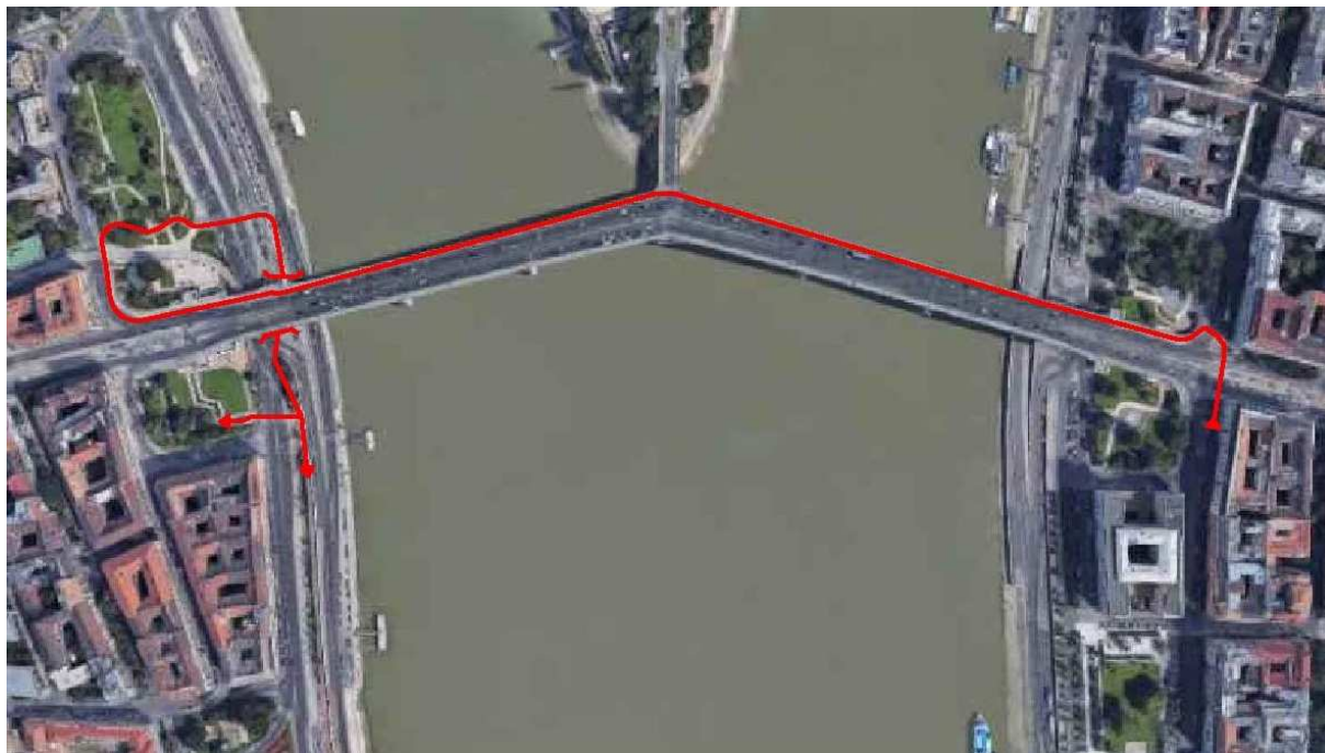
5. ábra [8] : Átkelés a híd dél pesti részéről a dél budaira
