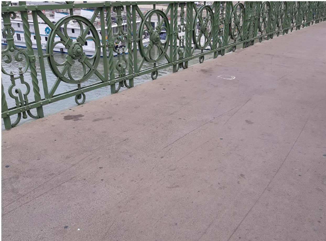
28. ábra: A Szabadság híd járdáján látható féknyomok
