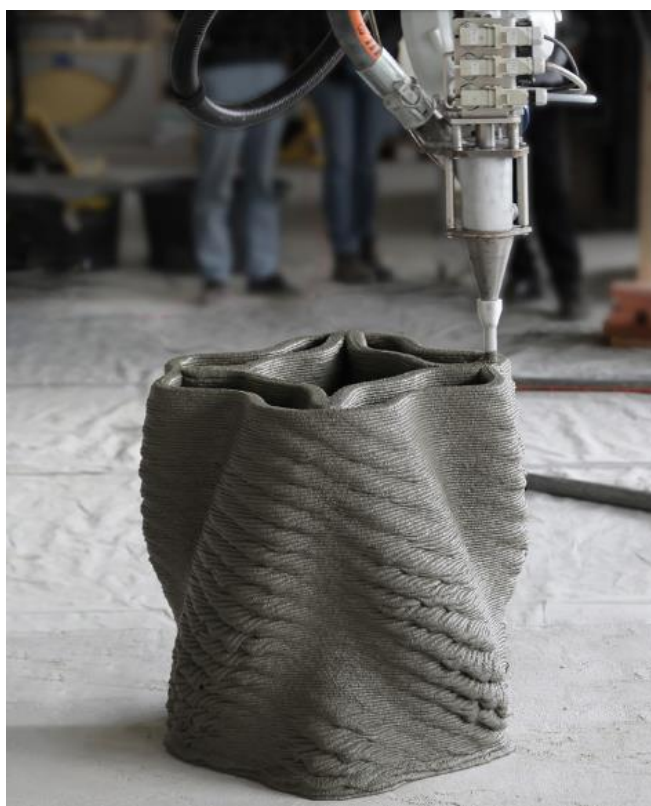
13. ábra: Egy tartóoszlop nyomtatása (Forrás: worldarchitecture.org)
