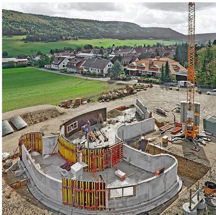
11. ábra: Gyakorlati példa egyenes és íves falszakaszokból álló monolit épületre (Forrás: PERI)
