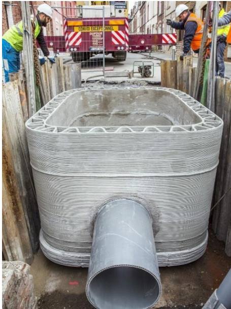
6. ábra: 3D nyomtatott beton akna (Forrás: Leolane)
